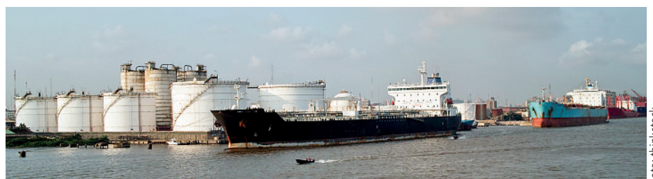
Nigeria ist nur einer der afrikanischen Staaten, der auf den Ausbau seiner Verkehrsinfrastruktur setzt.
